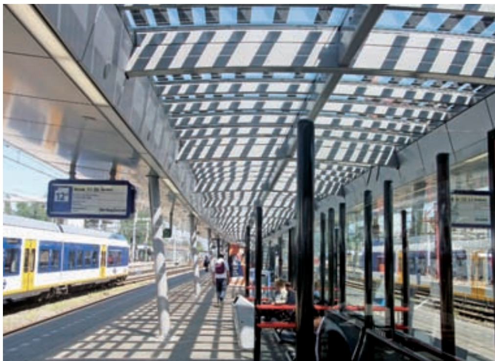
Bekroond met de European Aluminium Award 2012: overkapping met gebogen aluminium profielen en glas-op-glas zonnecellen.
