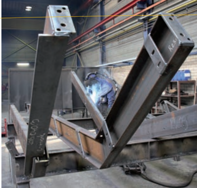
Het lassen van kromme delen zoals trapwerken blijft handwerk.
