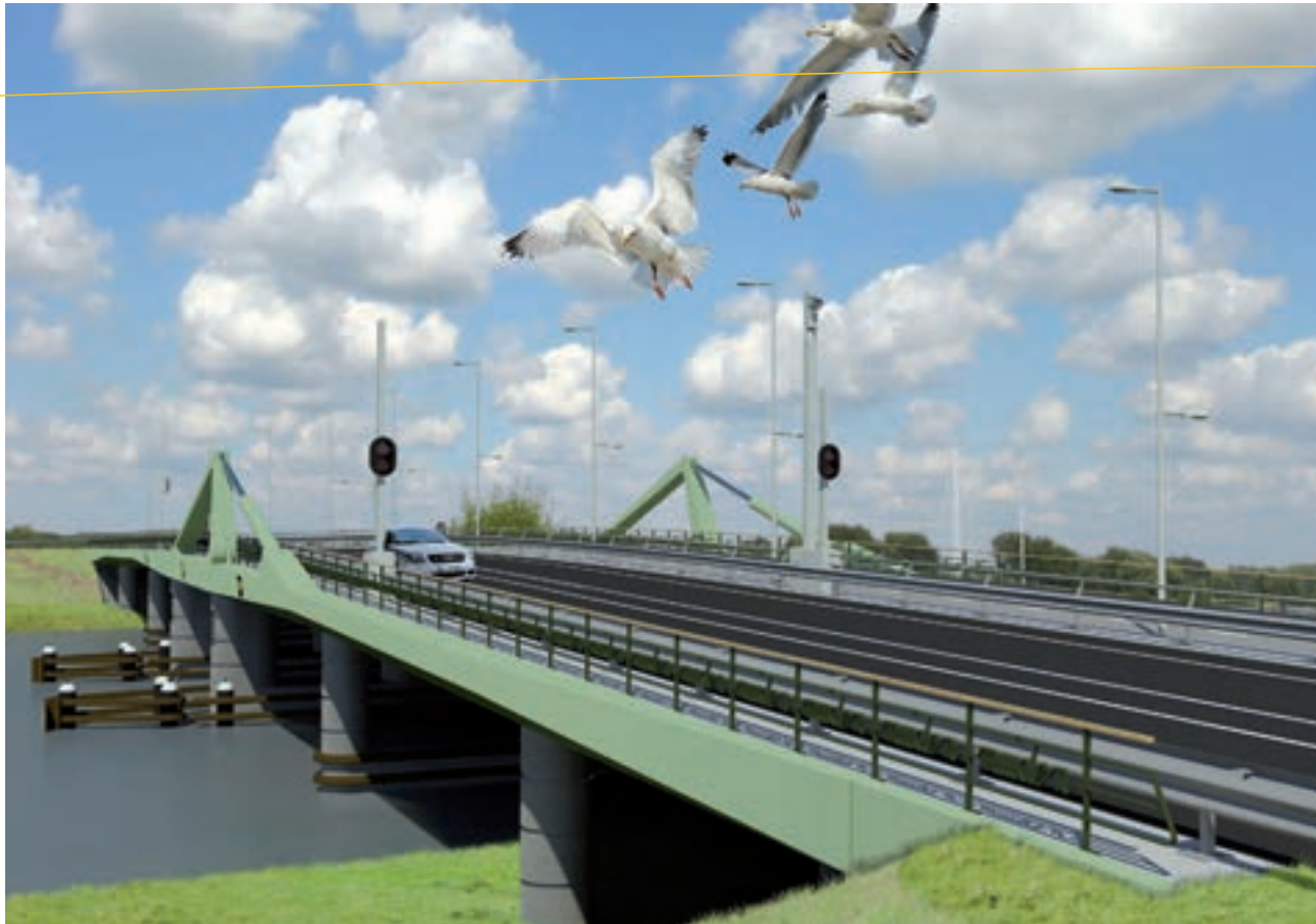
Het brugdek van de nieuwe Spieringbrug in Muiden wordt van composiet gemaakt (ontwerp: Quist Wintermans Architecten).
