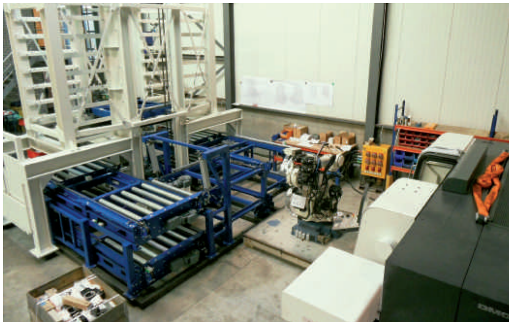
Een draaiceel in opbouw bij Swabo in Reusel die binnenkort een AutoCell freescel zal installeren voor de eigen productie en voor toelevering van 5-assig freeswerk in kleine tot middelgrote series.
