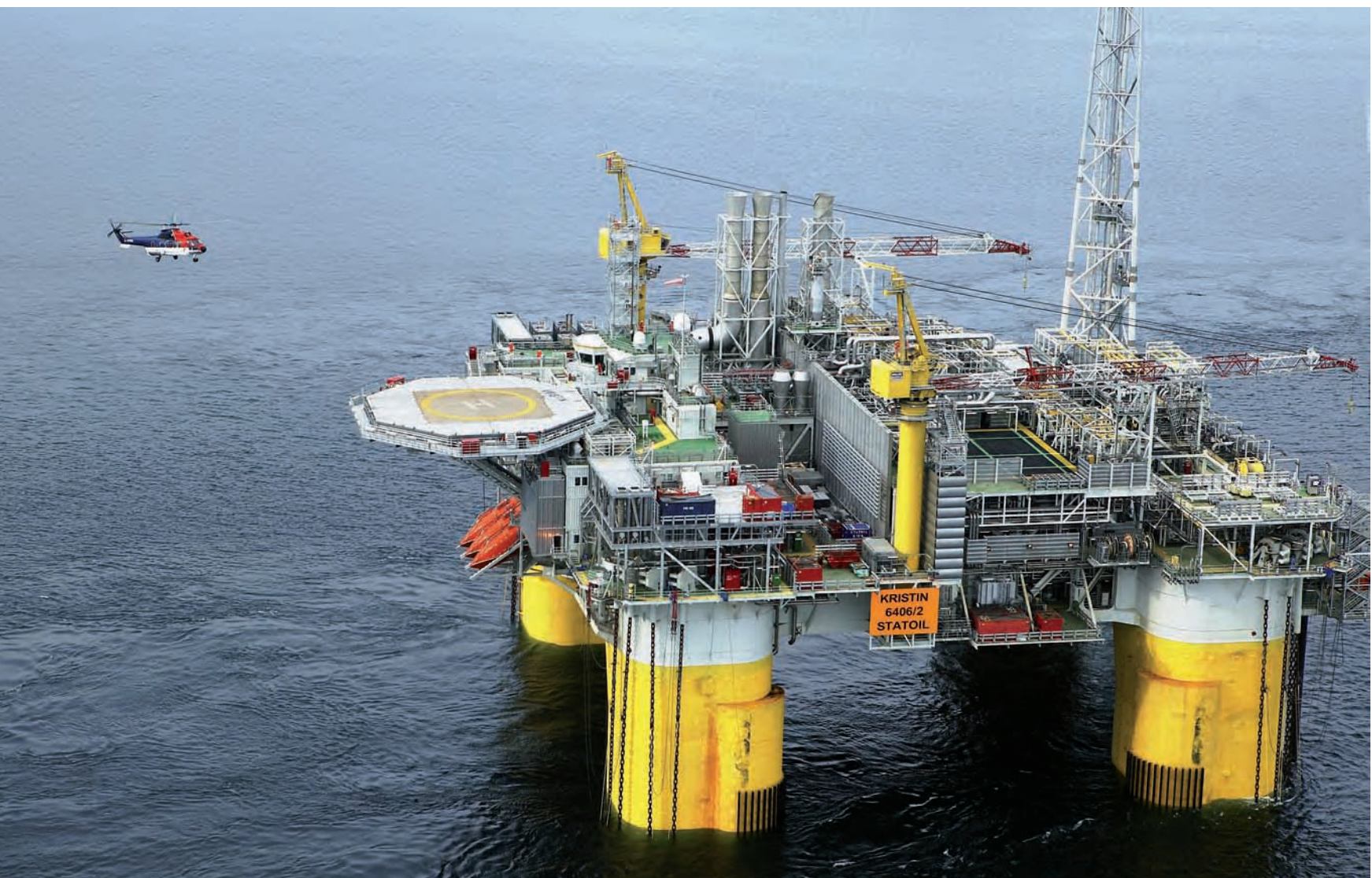
Aluminium helideck op het Noorse Statoil-platform Kristin. Alu-constructies in de offshore besparen gewicht, ten gunste van de primaire productie-installaties.
