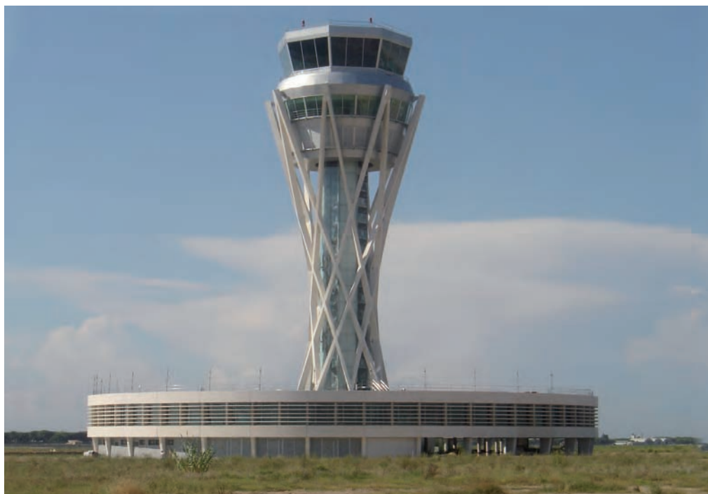
De verkeerstoren van Barcelona geldt als geslaagde synthese tussen architectuur, constructie, bouwefficiëntie en functionaliteit. Architect Bruce S. Fairbanks ontwierp dit nieuwe icoon voor stad en luchthaven.
