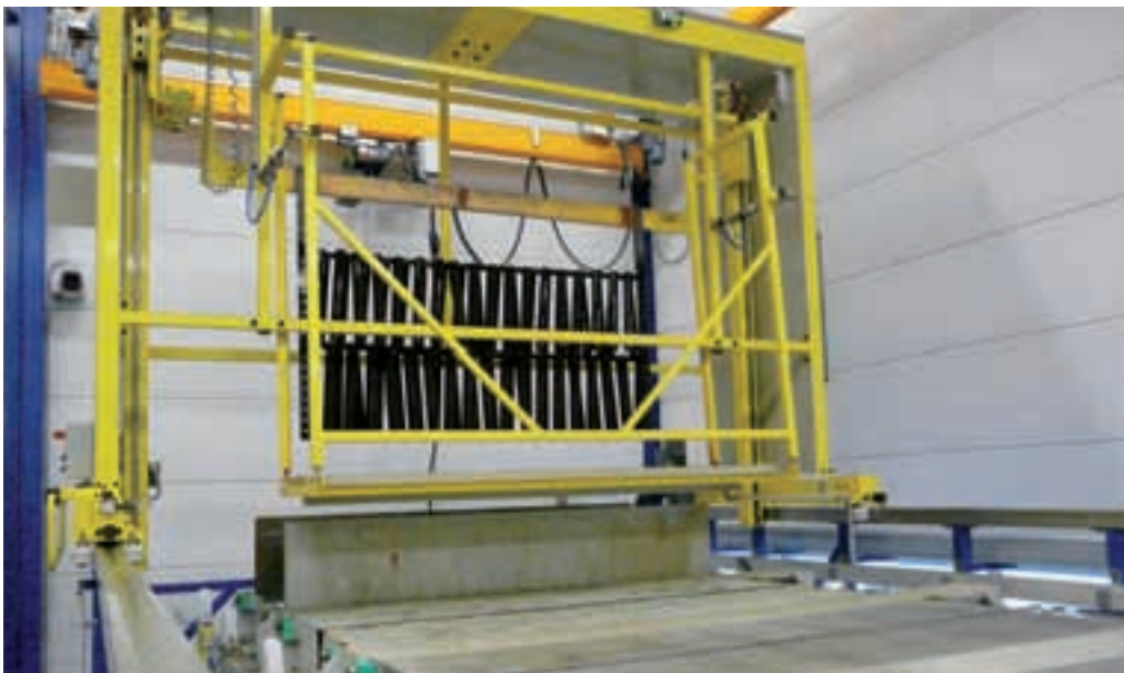
CZL Tilburg beschikt onder meer over deze computergestuurde oppervlaktebehandelingsstraat. De producten aan de conveyor zijn chemisch gezwart.
