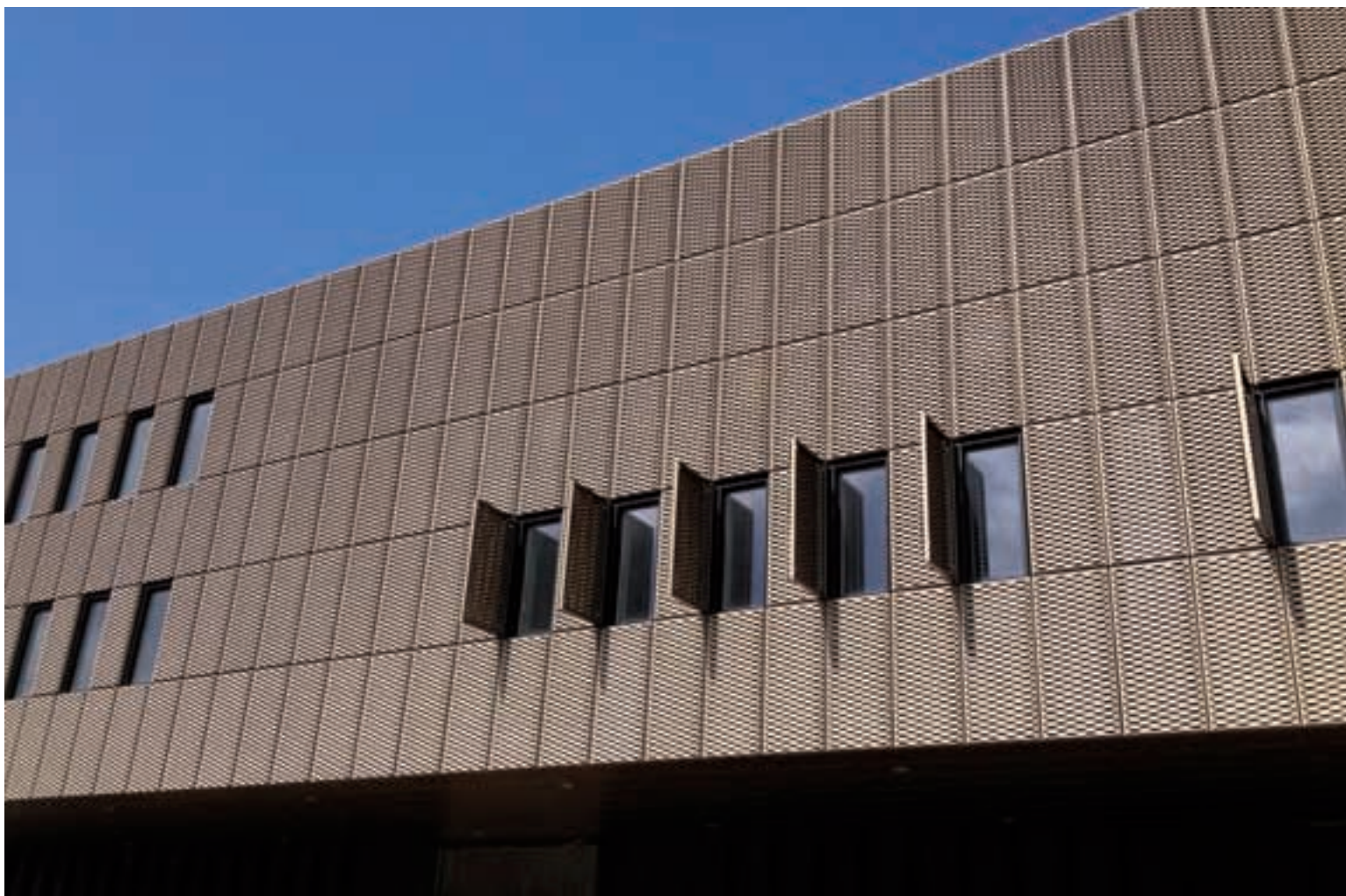
Lichtbrons geanodiseerd strekmetaal voor het datacenter van de Koninklijke Universiteit Leuven.
